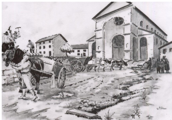
Figure 9.4: Démolition de la vieille église.
